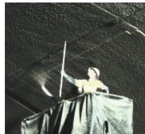
Son sistemas diseñados para la aplicación sobre superficies estructurales críticas a fin de volverlas resistentes al fuego con altas temperaturas durante un período de tiempo o para cerrar pasos de aire que propaguen fuego.
